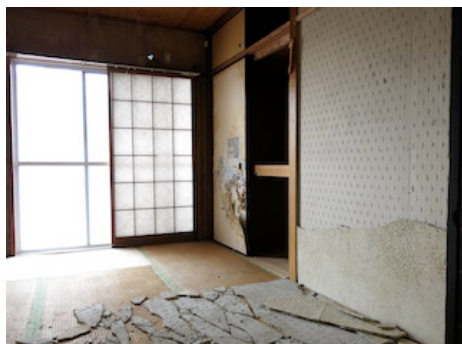
▲施工前（部屋全体）
